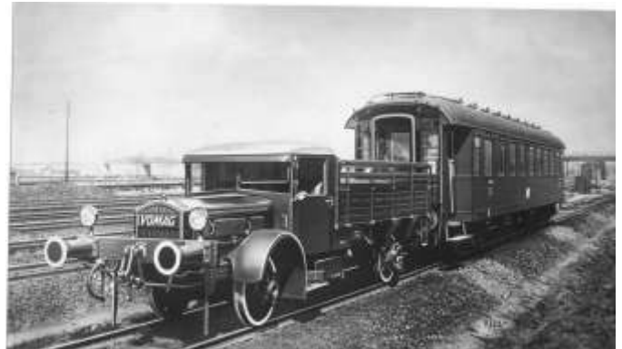
Einer der wenigen VOMAG – Sechseinhalbtonner, die im Krieg für den Einsatz auf der Schiene umgerüstet wurden.
